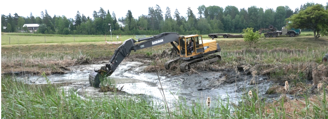
Figur 10 Utgrävning med grävmaskin 20 ton.
