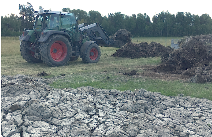
Figur 12 Sediment upplagt för avvattning. Här syns hur sedimentet flutit ut.
